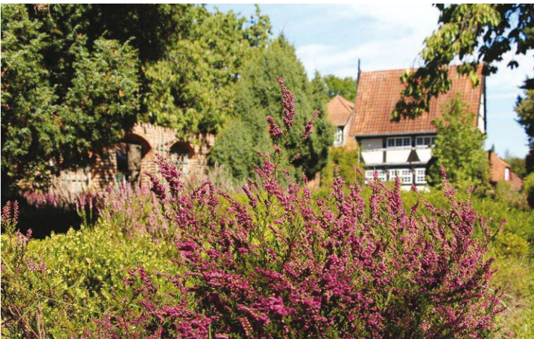
Blick auf den Lehgarten und den Treppenspeicher.
