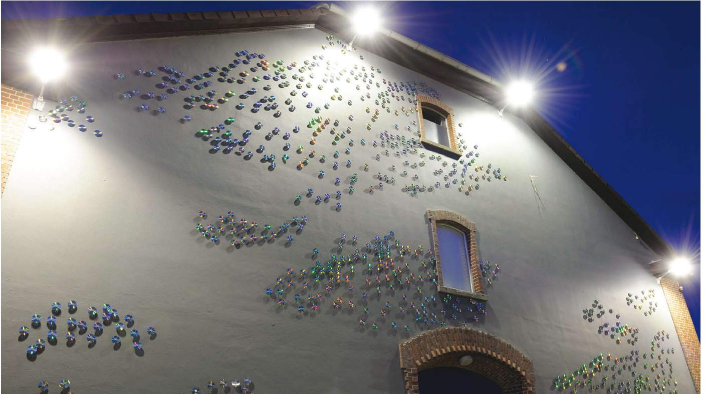
Die Cambridge-Dröner-Kaserne: Glitzer an der Fassade...
